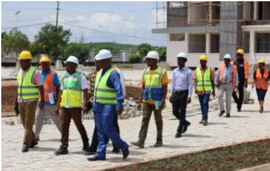
Naibu Katibu Mkuu wa Wizara ya Katiba na Sheria Dkt. Khatibu Kazungu akitembelea na kukagua ujenzi wa jengo la Wizara, tarehe 29 Desemba, 2023 Mji wa Serikali Mtumba
